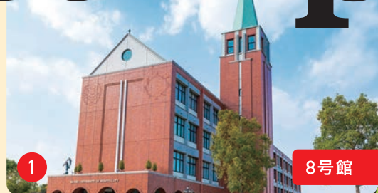
川越キャンパス「フローラ館」 (狭山キャンパス隣接) 地上4階建て、レンガ造りのフローラ館。看護の教育内容に対応した設備があります。
